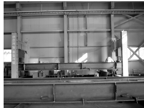
〈사진 6〉 선행하중재하 중 고강도강판 용접
