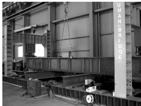
〈사진 4〉 가제작주형 거더 재하대 거치
